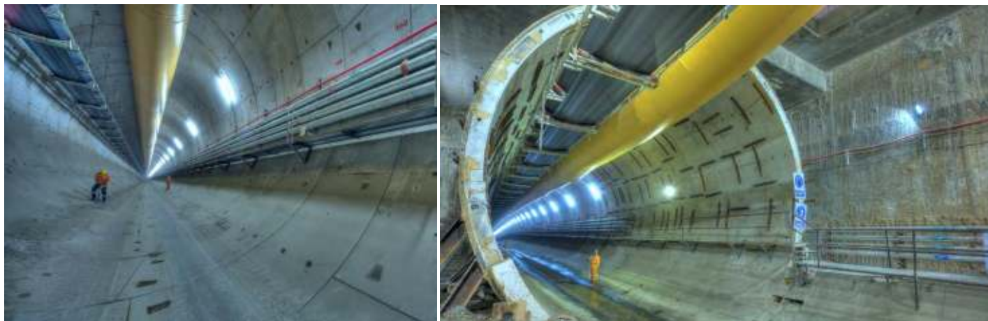
Fotos: Túnel estación El Labrador – estación Jipijapa
