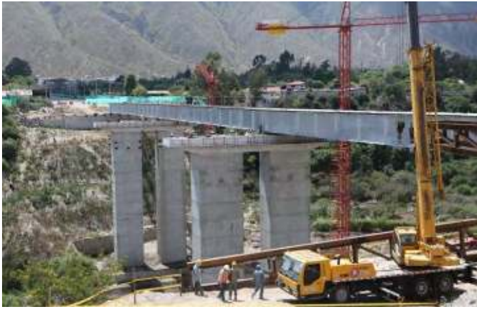
Foto: Construcción puente de Los Pájaros
