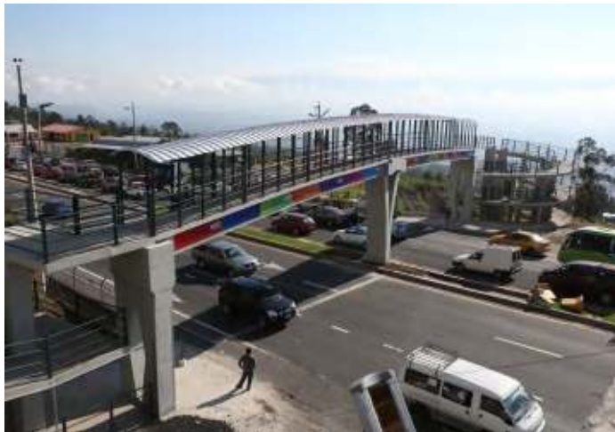
Foto: Puente peatonal Ruta Viva
