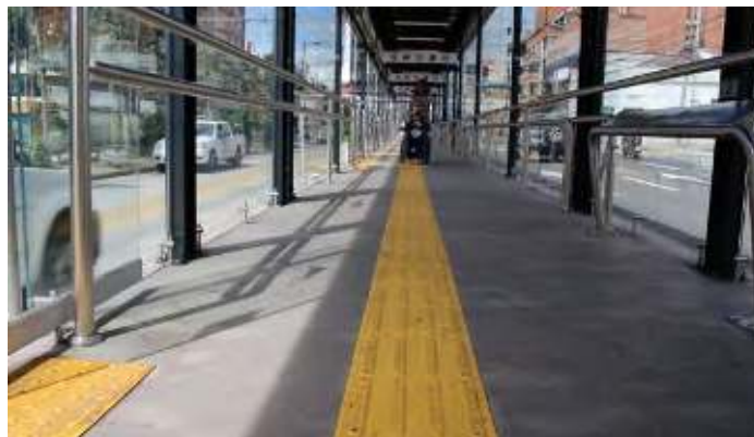
Foto: Parada remodelada con accesibilidad universal
