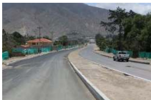
Foto: Prolongación Simón Bolívar
