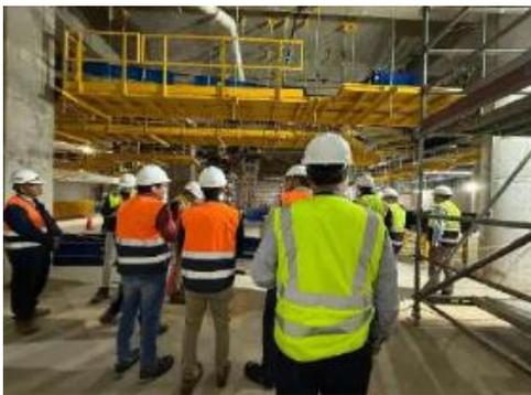
La ampliación de 17.200 m<sup>2</sup> la terminal de pasajeros mantiene un proceso de construcción según lo establecido en el cronograma, con avance en los 4 niveles del edificio; se incluyen trabajos de instalaciones eléctricas, mecánicas, sistema de bandas de equipaje (BHS), ascensores, cierre de fachadas con alucobond y mamparas de vidrio, entre otros.
