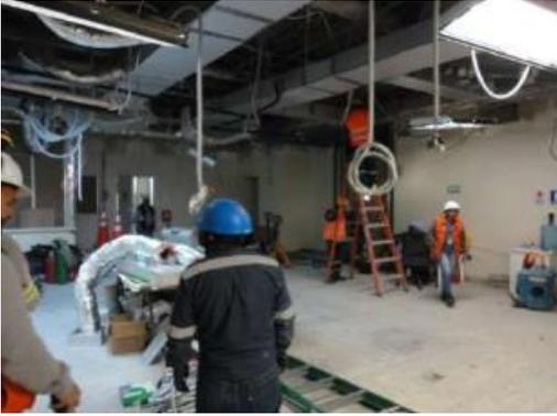
Se dio inicio a la remodelación de 91 m<sup>2</sup> del Centro de Monitoreo CCTV. Hasta marzo 2025 se realizó el desmontaje de cielo falso, el retiro de instalaciones eléctricas y datos que quedan inoperativos, y se colocaron los condensadores de los 2 equipos de aire acondicionado. Inversión: USD 300.000.
